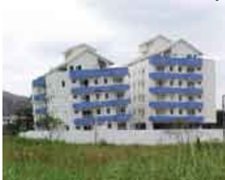
Figura 1: após uma falha no pavimento térreo o prédio em destaque desabou (Ubatuba/SP).
