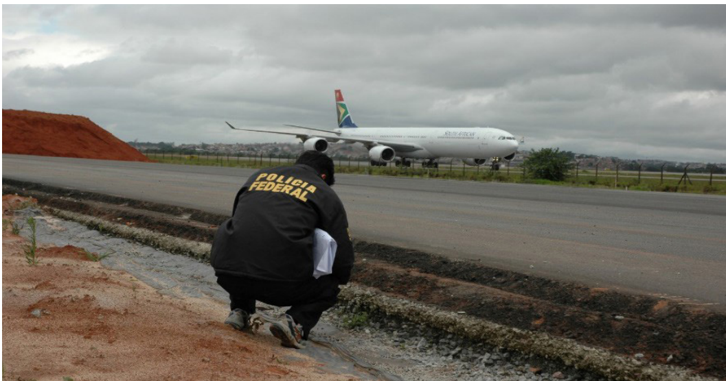
Figura 1 – Exame de quantitativos e especificações técnicas em pavimento aeroportuário.
