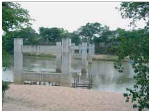
Foto 7 – Execução parcial de mesoestrutura de obra de arte especial
