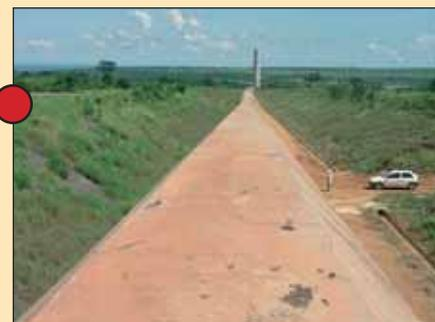
**Fig. 3** – Detalhe de conduto em concreto da PCH, com torre de alívio ao fundo
