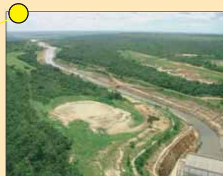
**Fig. 4** – Vista do canal 02 da PCH, escavado em rocha
