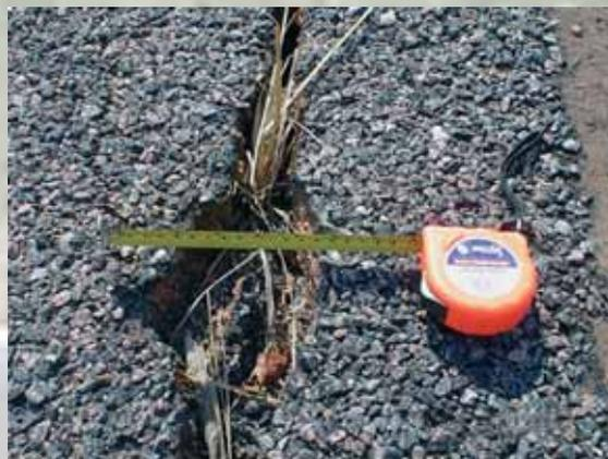
Foto 5 – Fissura com erosão de borda no acostamento
