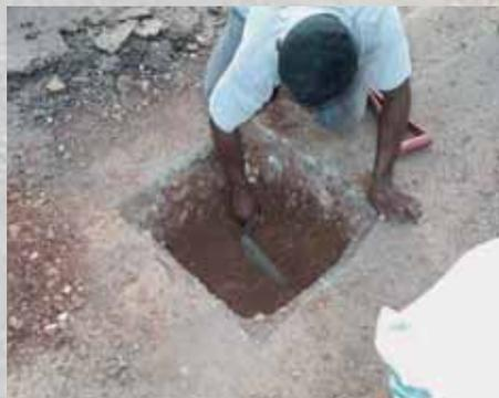
Foto 2 – Execução de sondagem para medição de espessuras e coleta de materiais para ensaios
