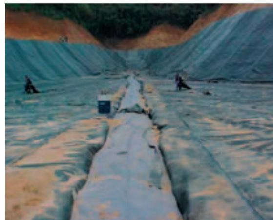
**Foto 02** – Construção de um aterro sanitário do tipo trincheira
