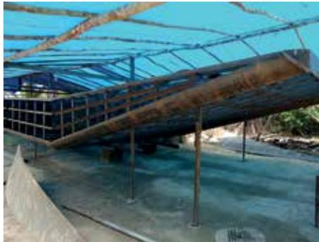
Figura 24. Balsa de logística em construção, localizada em um estaleiro montado em ilha do Rio Teles Pires
