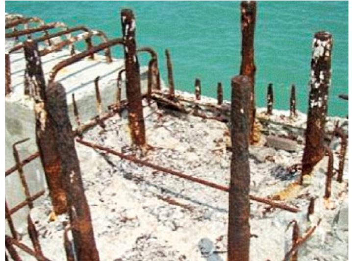
Oxidação das armaduras de espera, sem proteção adequada.
