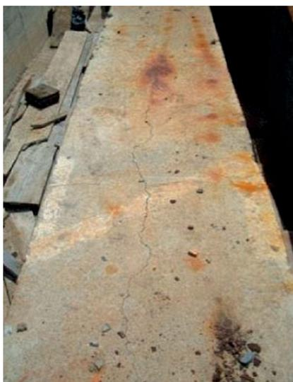
Fissuração Longitudinal da superfície de viga.
