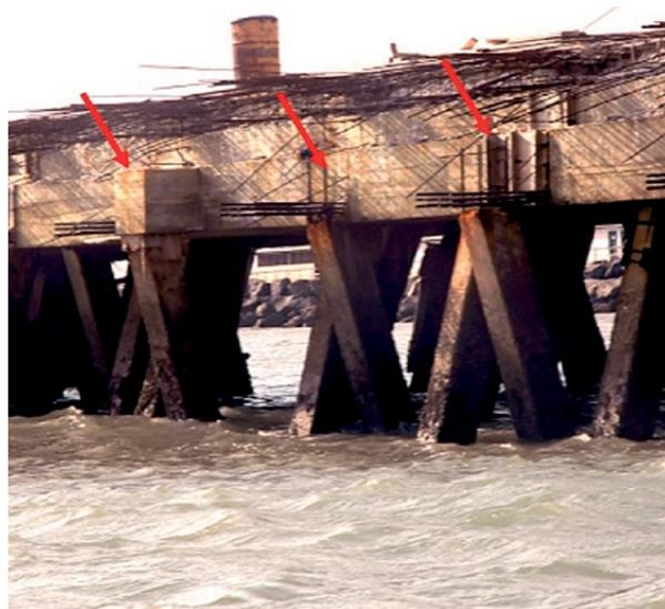
Execução de estacas fora da posição, com deslocamento superior a 4,5cm.
