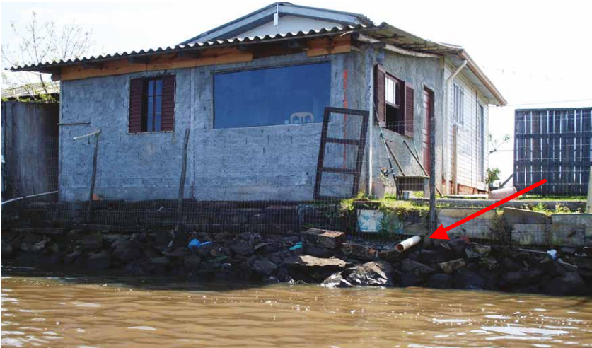
Fig. 5 – à direita – Detalhe do ponto de lançamento de esgoto (cano subterrâneo).
