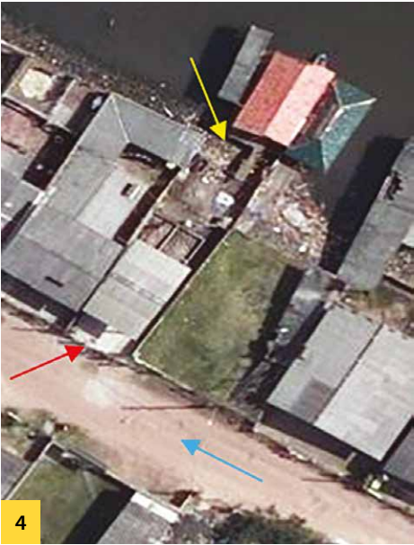
Fig. 4 – à esquerda – Vista da área examinada, com indicação da localização do imóvel, do ponto de saída de esgoto e da Travessa Tarrafa (setas vermelha, azul e amarela, respectivamente).
