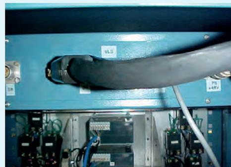
Traseira do painel de comando, com destaque do cabo que vai ao foguete, antes passando por painel no subsolo da sala de comando do disparo.
