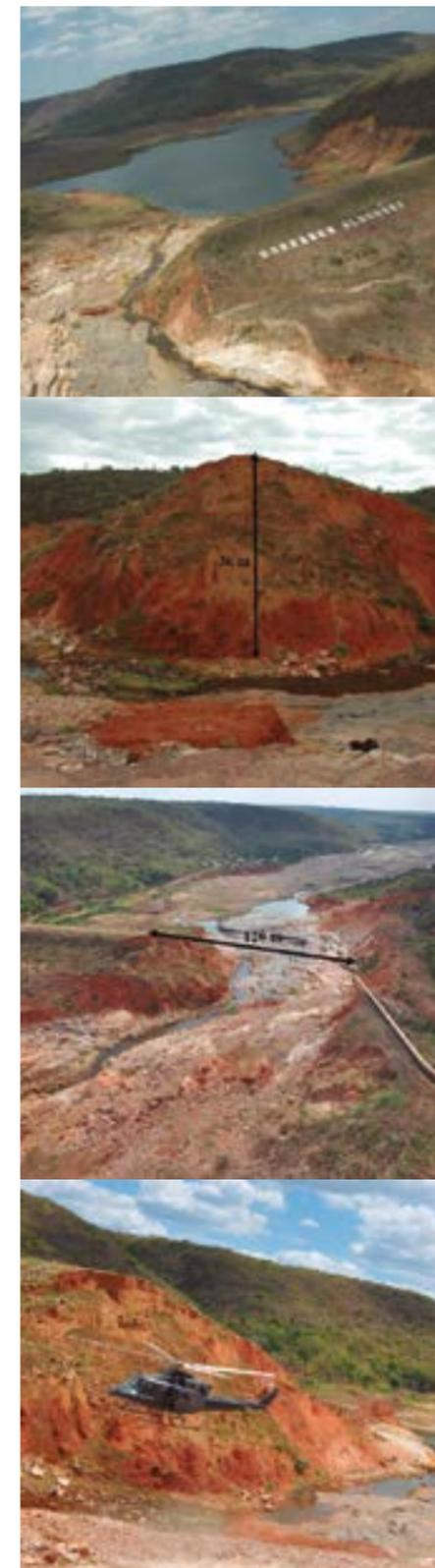
Figura 1: Rompimento da barragem de Algodões no município de Cocal/PI em 2009.
