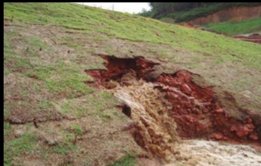
Imagem do vazamento com carreamento de material ou Piping, ocorrido em 13 de abril de 2009, acima da saída do dreno de fundo principal, que foi mal construído. (ref.: APPENDIX A – Fotos).
