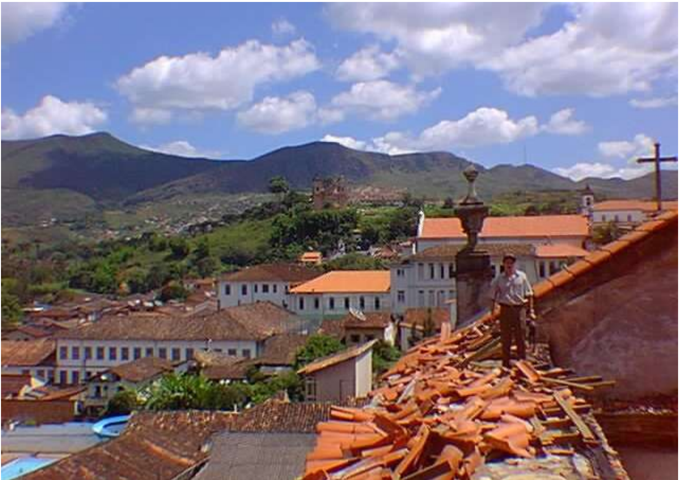
Perito Criminal Federal João Luiz Moreira de Oliveira no telhado da Igreja do Carmo em 1999, onde iniciou sua trajetória em perícia de incêndios.
